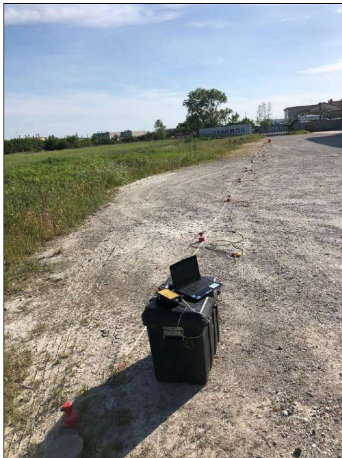
Sito: nuovo tratto stradale Santa Croce sull'Arno - PI Data: Maggio 2021
