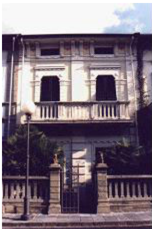
Fig. 1.1 – In questo elemento edilizio primo '900 è evidente il rapporto di coerenza formale tra facciata e recinzione
